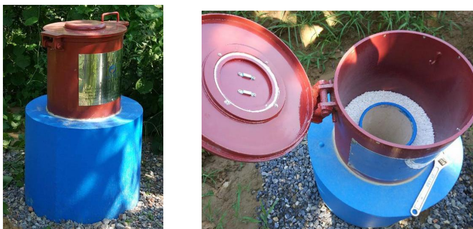
图 2 已安装井口保护装置图片
